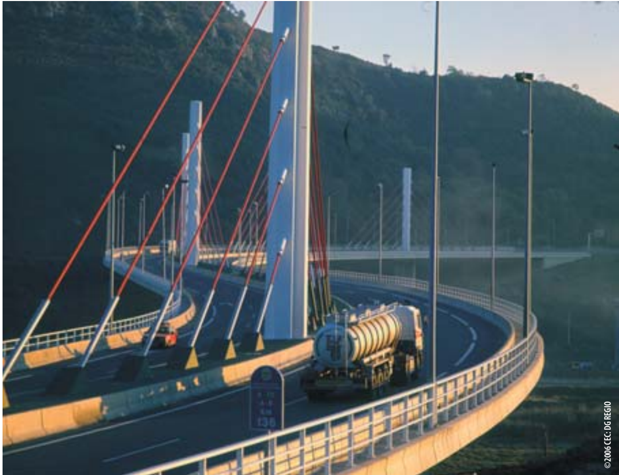
Viaduc de la nouvelle autoroute Bilbao – Santander, près de Las Arenas, Pays Basque (Espagne)
