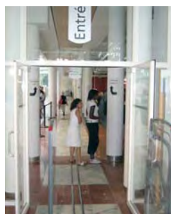
Large portillon, sol en marbre avec lignes guides, à l'entrée de la bibliothèque de l'Alcazar à Marseille.
