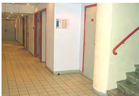
Repérage contrasté des portes et de l'escalier au musée des Beaux-Arts et de la Dentelle de Calais.
