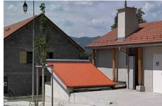
Chaufferie bois La Rivière (38)
