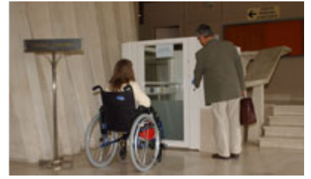
Palais de Justice de Beauvais (60), système d'élévation pour fauteuil roulant
